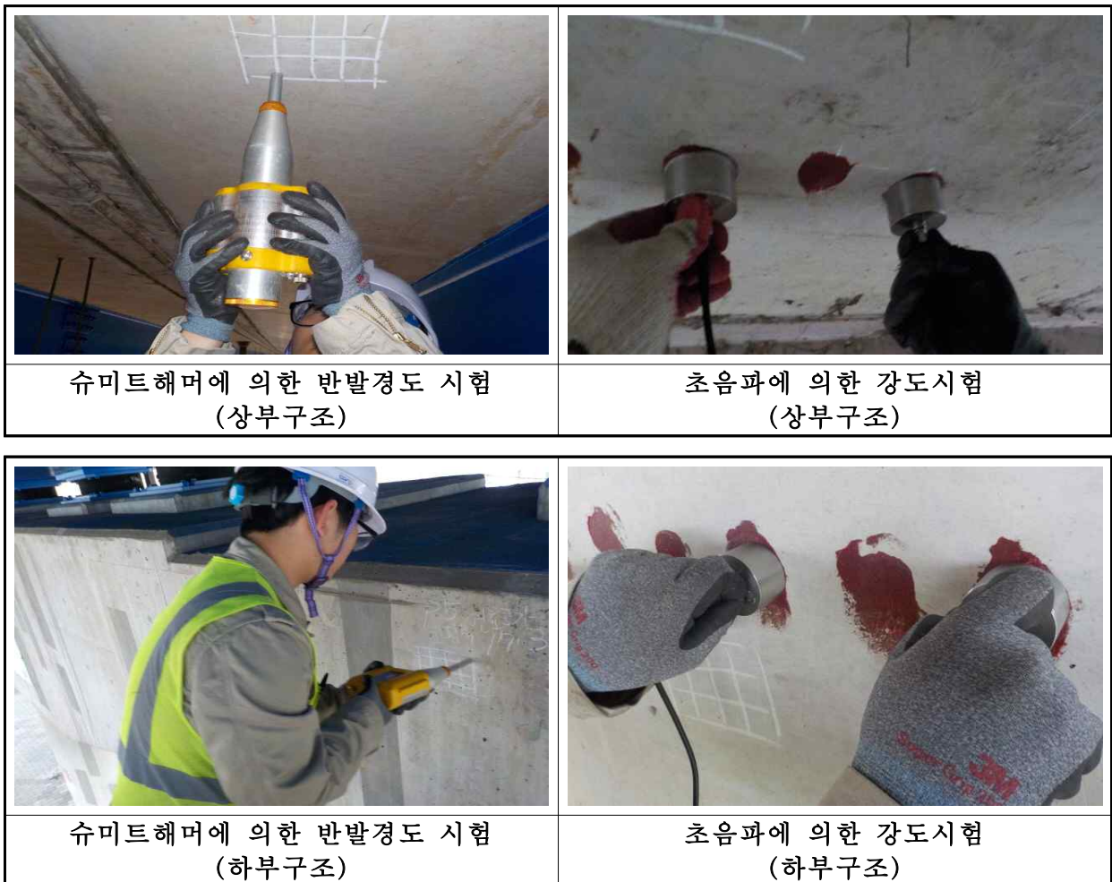
<그림 3.2.1> 콘크리트 비파괴강도시험현황
