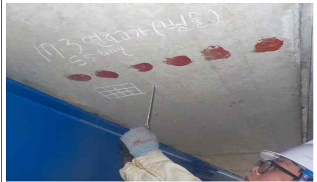
탄산화 시험(버니어캘리퍼스 측정)
